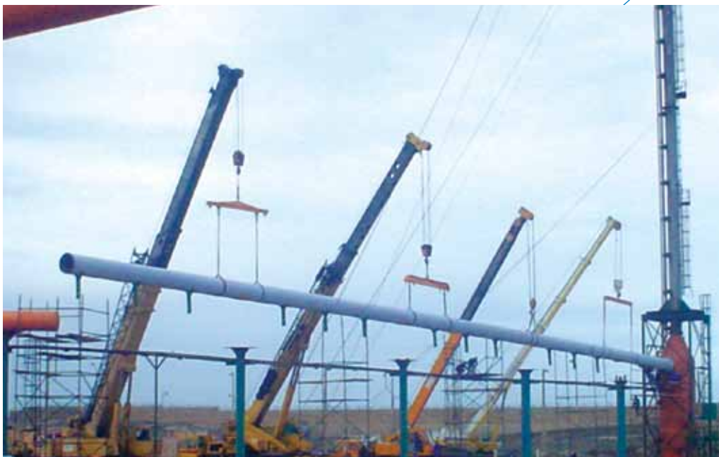
Substituição da linha "blow-down" 36" para a Refinaria da Mohammedia
